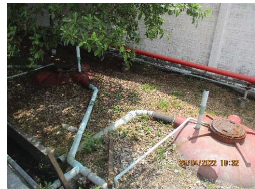
รูปที่ 3-6 ถังดักไขมันในส่วนของโรงซ่อม
