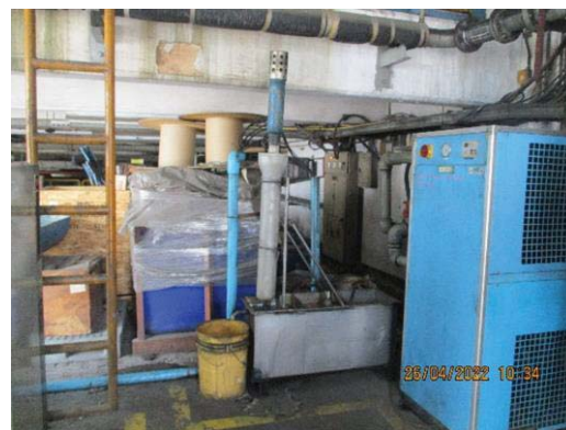
รูปที่ 3-8 ระบบกรองน้ำมันจากปั๊มลม
