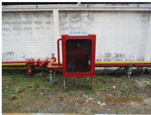
รูปที่ 3-34 ติดตั้งหัวจ่ายน้ำและท่อจ่ายน้ำดับเพลิงรอบโรงงาน
