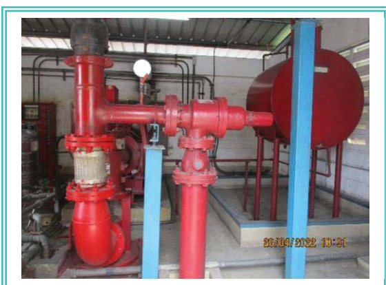
รูปที่ 3-31 ติดตั้งระบบปั้มน้ำดับเพลิง
