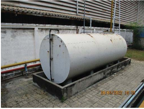
รูปที่ 3-1 ถังรวบรวมน้ำเสียจากการผลิต รอส่งกำจัด
