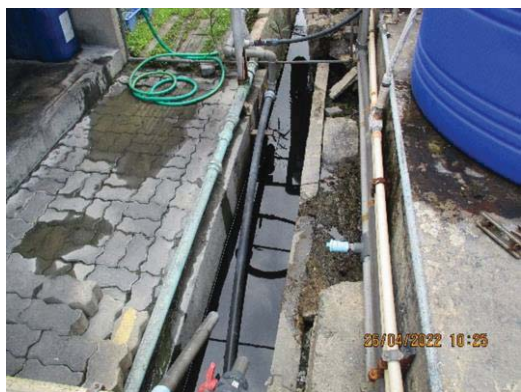
รูปที่ 3-7 รังระบายน้ำทิ้งจากหอหล่อเย็น
